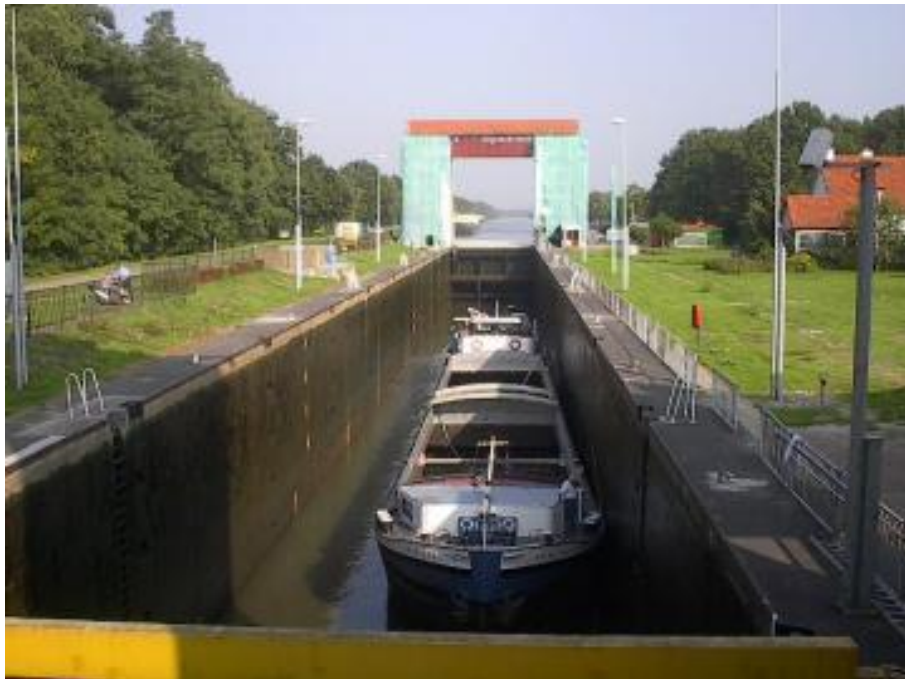
Figuur 2: De sluis op vaarroute bepalend voor lengte van schip, bron: Wikipedia
